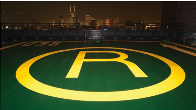
ヘリサイン Rパターン 某マンション屋上 通気緩衝工法
