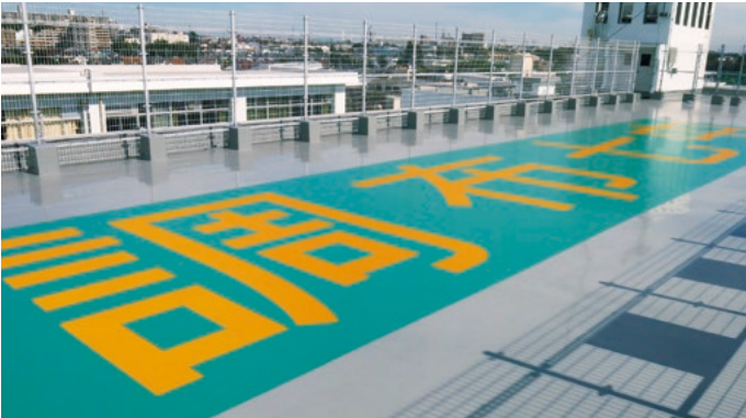
ヘリサイン 文字パターン 中学校校舎屋上 密着防水工法
